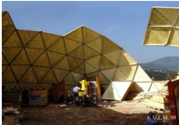
Abbildung 1: Teil des Doms im Aufbau, Montage Frankenberger, 1994
